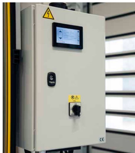
Armario de distribución de la EFA-ProfiNetSafe®
